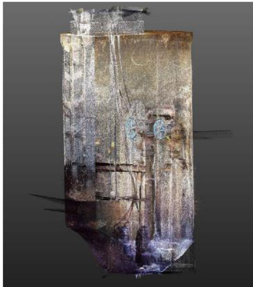
Pumpenschacht DN 2000 mit Doppelpumpenanlage
