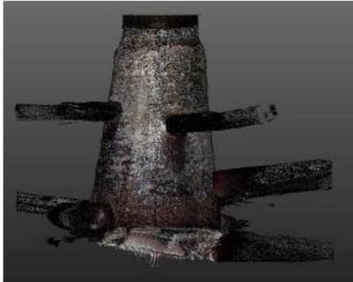
Konischer Betonschacht mit vielen versetzten Zuläufen
